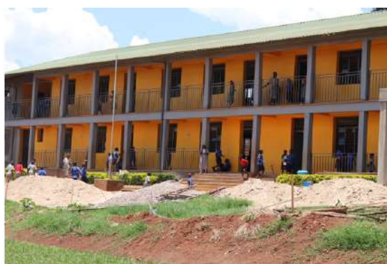
Lavori in corso alla scuola primaria Luigi Giussani di Kampala
